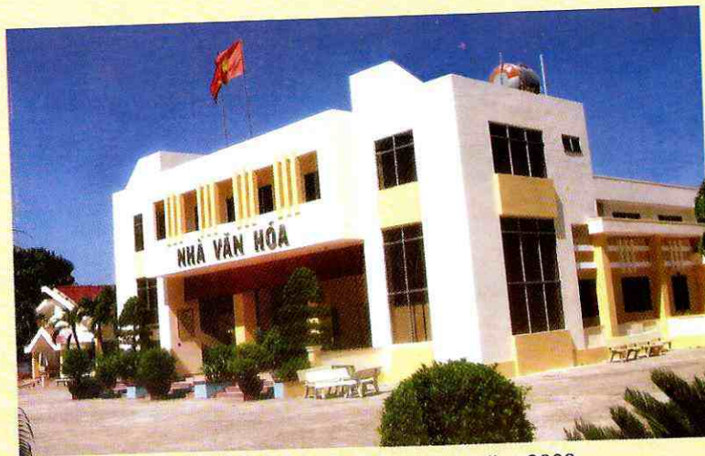
Nhà văn hóa huyện hoàn thành năm 2002.
