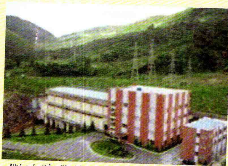
Nhà máy thủy điện Hàm Thuận (xã Đa Mi) vận hành năm 2001, công suất 300MW.
